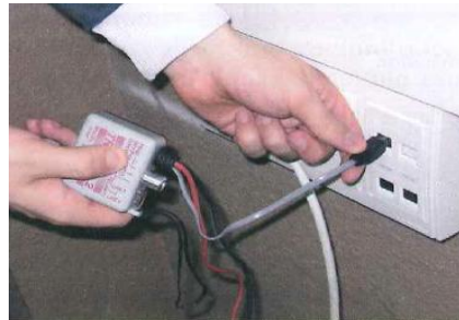
Conexión del generador en modo TONE, a una roseta que deseamos comprobar
